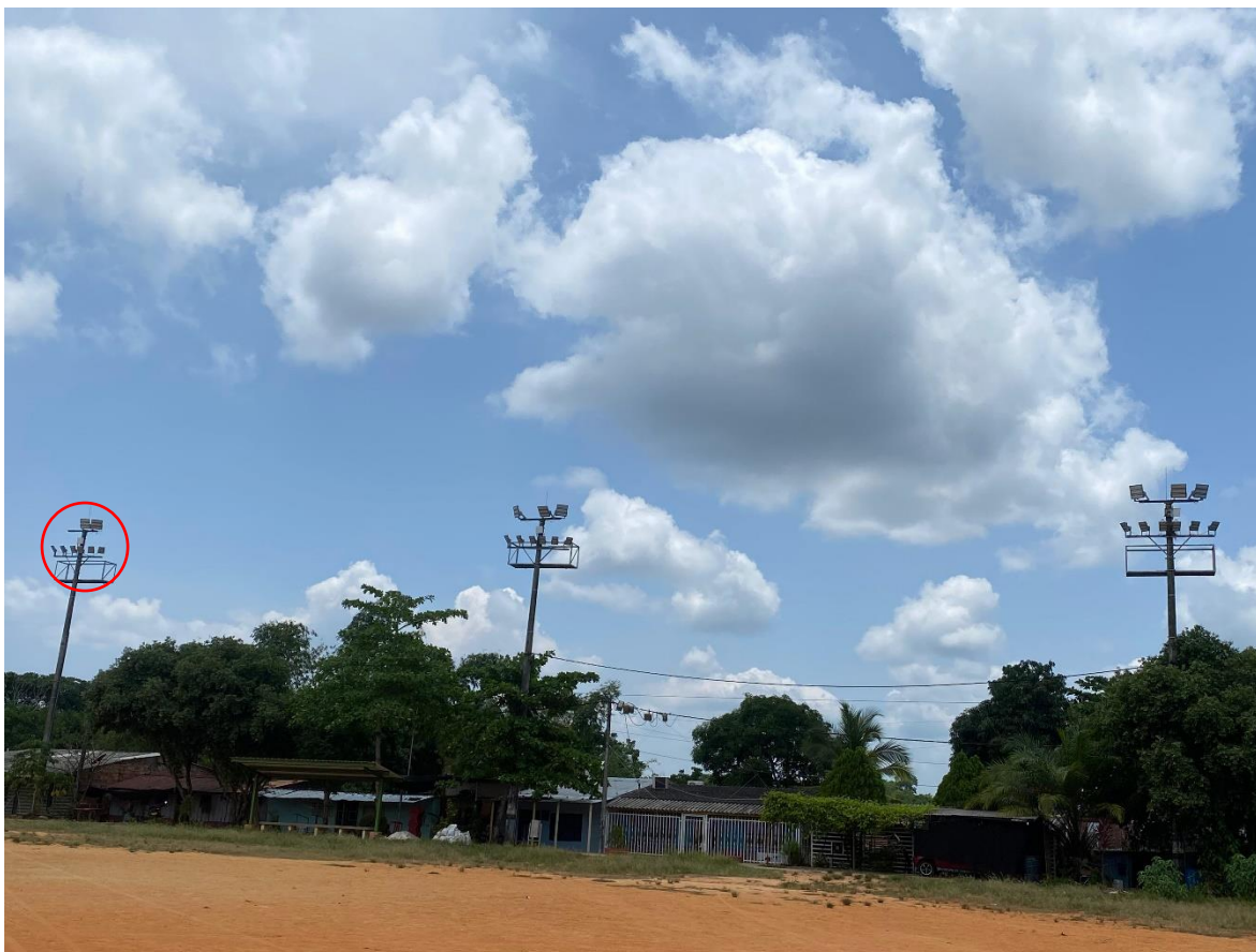
Cancha de fútbol (el guamo) corregimiento del Llanito (modernización)
