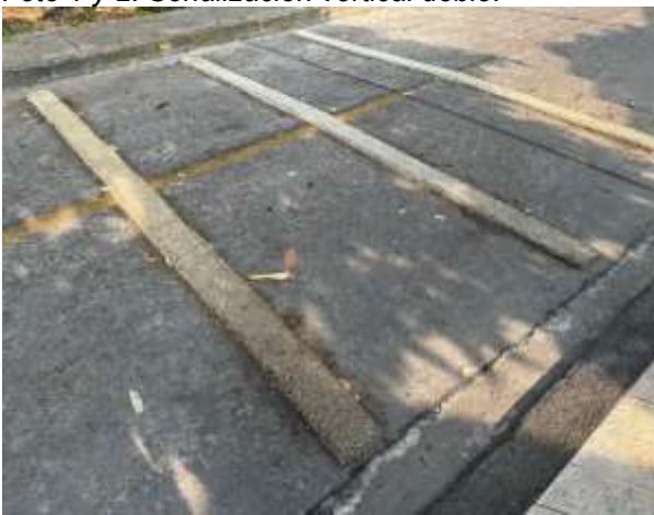
Foto 3 y 4. Construcción de banda sonora reductoras de velocidad.
