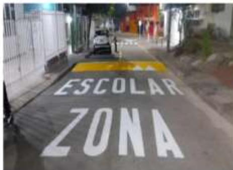
REGISTRO FOTOGRAFICO OBRAS CONTRATO 078-2023 CONTRATISTA: GSO INGENIERIA Y SOLUCIONES SAS RESALTOS PARABOLICOS
