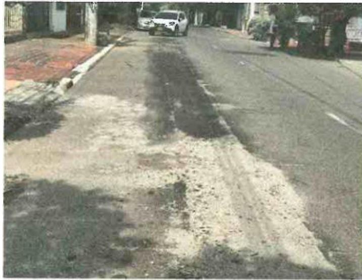
Registro fotográfico visita de campo de la obra En esta se evidencia no existe zanja abierta o desnivel en la vía, que se pueda constituir como un riesgo en la zona el tránsito vehicular del sector intervenido de la calle 47 entre carrera 16/17.
