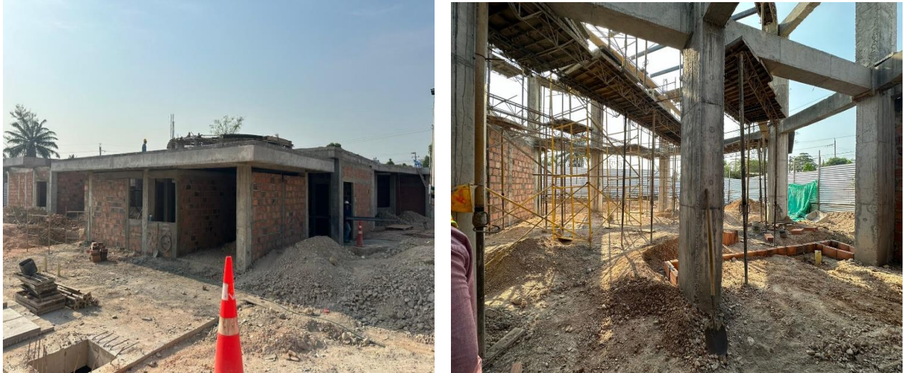
FOTO 8 - AVANCE EN OBRA CENTRO DE SALUD SIN CAMAS LA FLORESTA.
