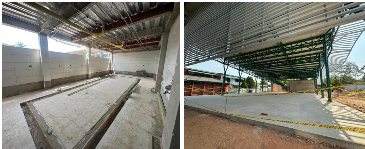
FOTO 7 - AVANCE EN OBRA COMEDERO ESCOLAR.
