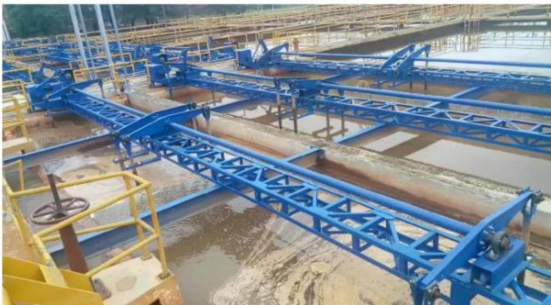
Imagen 2. Flocladores nuevos- sedimentador No.4
