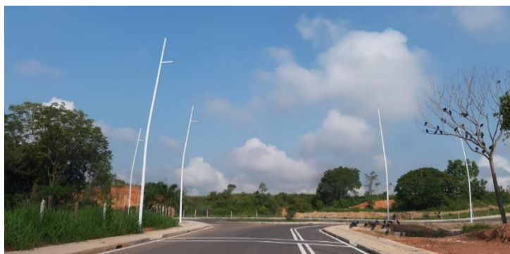
Evidencia fotográfica instalación de poste metálico.
