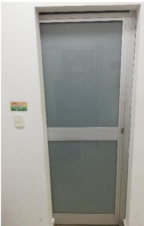
ENTRADA DATA CENTER
