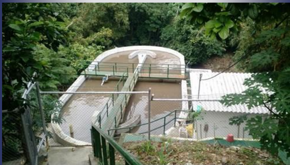
Foto Planta de Tratamiento de Agua Residual Torres del Campestre.
