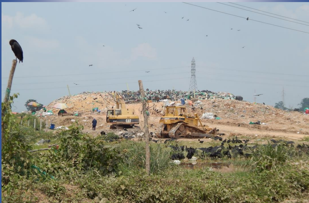
Foto No 1. Problemática de Lixiviados celda transitoria Sitio disposición final de Residuos Sólidos Municipio de Barrancabermeja
