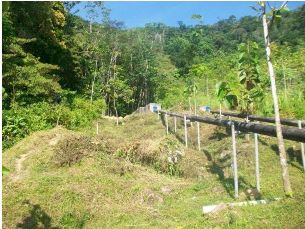
Foto No 26. Instalación de Tubería sobre marco H
