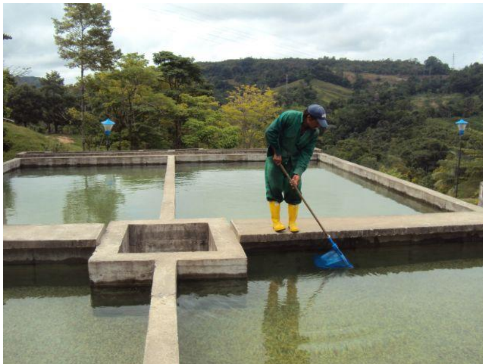
Foto No 31. Filtros Gruesos Finalizado
