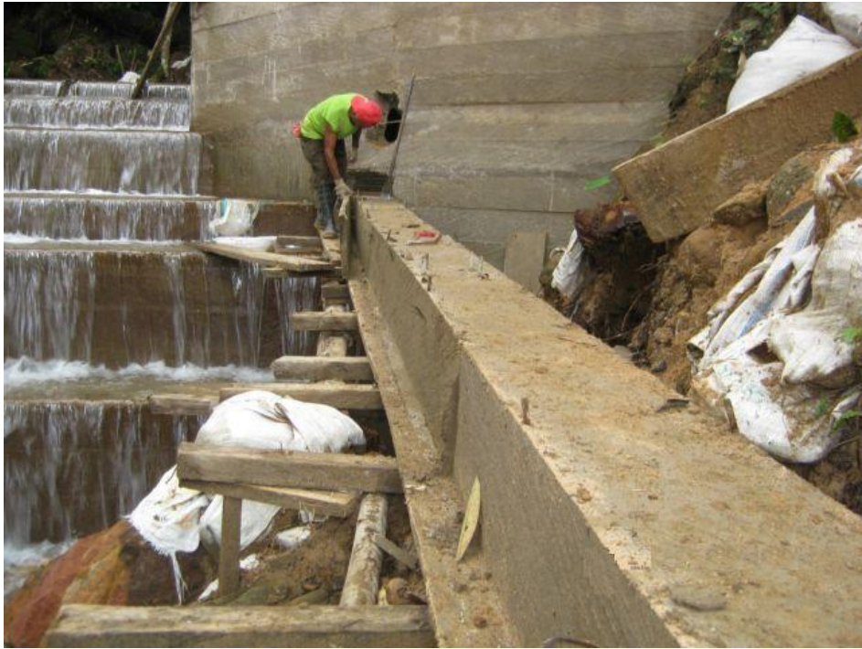
Foto No 20. Viaducto en concreto para la conducción bocatoma - Desarenadores
