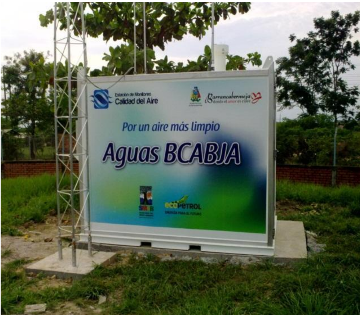
Foto No 9. Estación Fija de Monitoreo de Calidad de Aire en Barrancabermeja A.B.A S.A. E.S.P.
