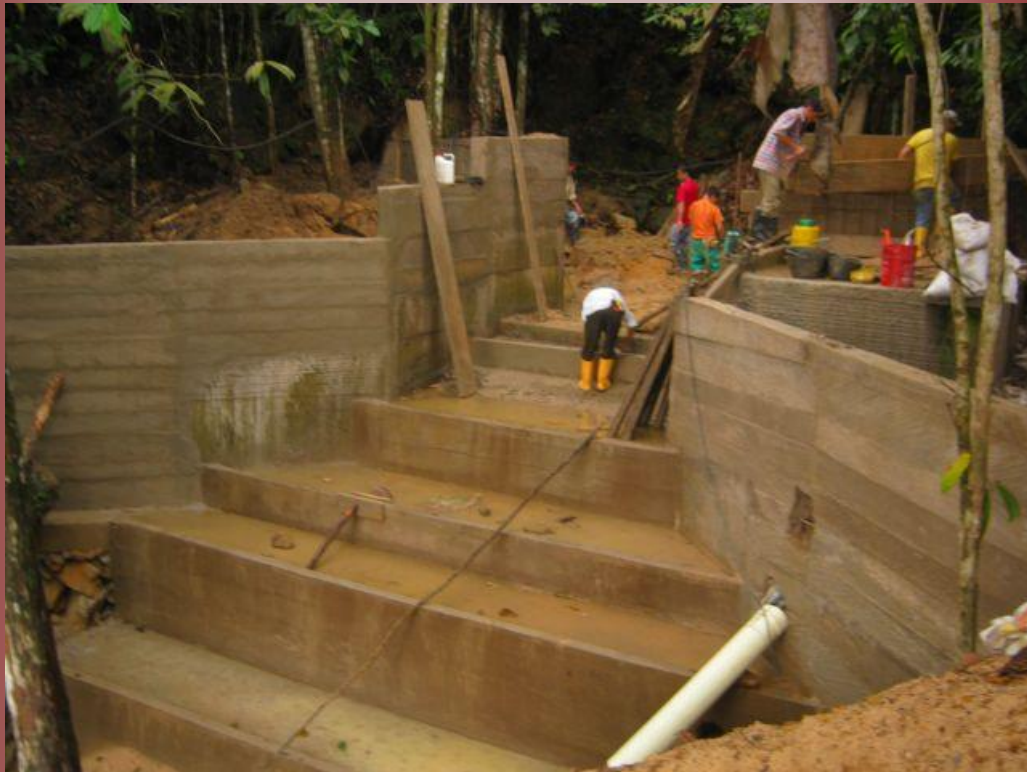
Foto No 11. Disipador de energía para la bocatoma del acueducto
