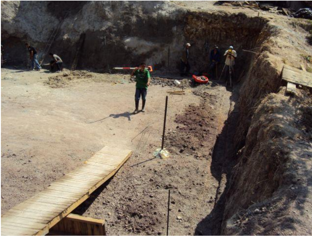
Foto No 37. Localización y replanteo Topográfico
