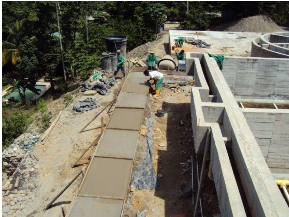
Foto No 34. Construcción de Andenes
