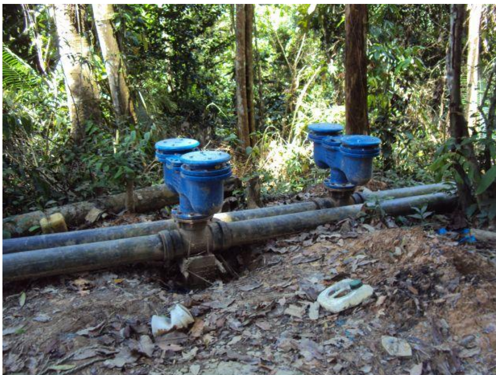
Foto No 27. Instalación de Ventosas 6" Tubería
