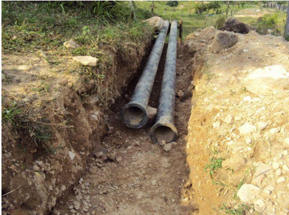
Foto No 25. Excavación e instalación Tubería
