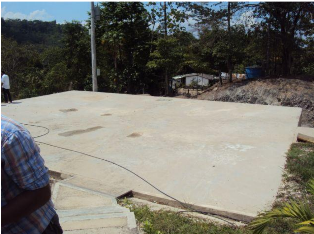
Foto No 40. Tanque de almacenamiento terminado
