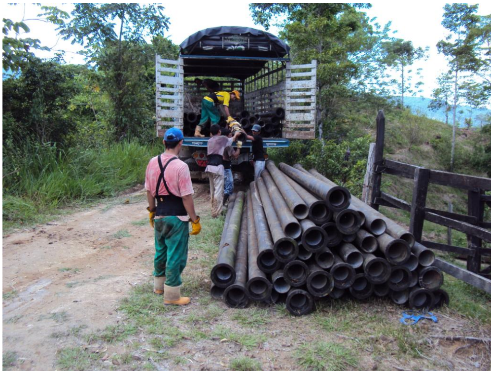
Foto No 24. Descargue de Tubería a orilla de la quebrada la Putana
