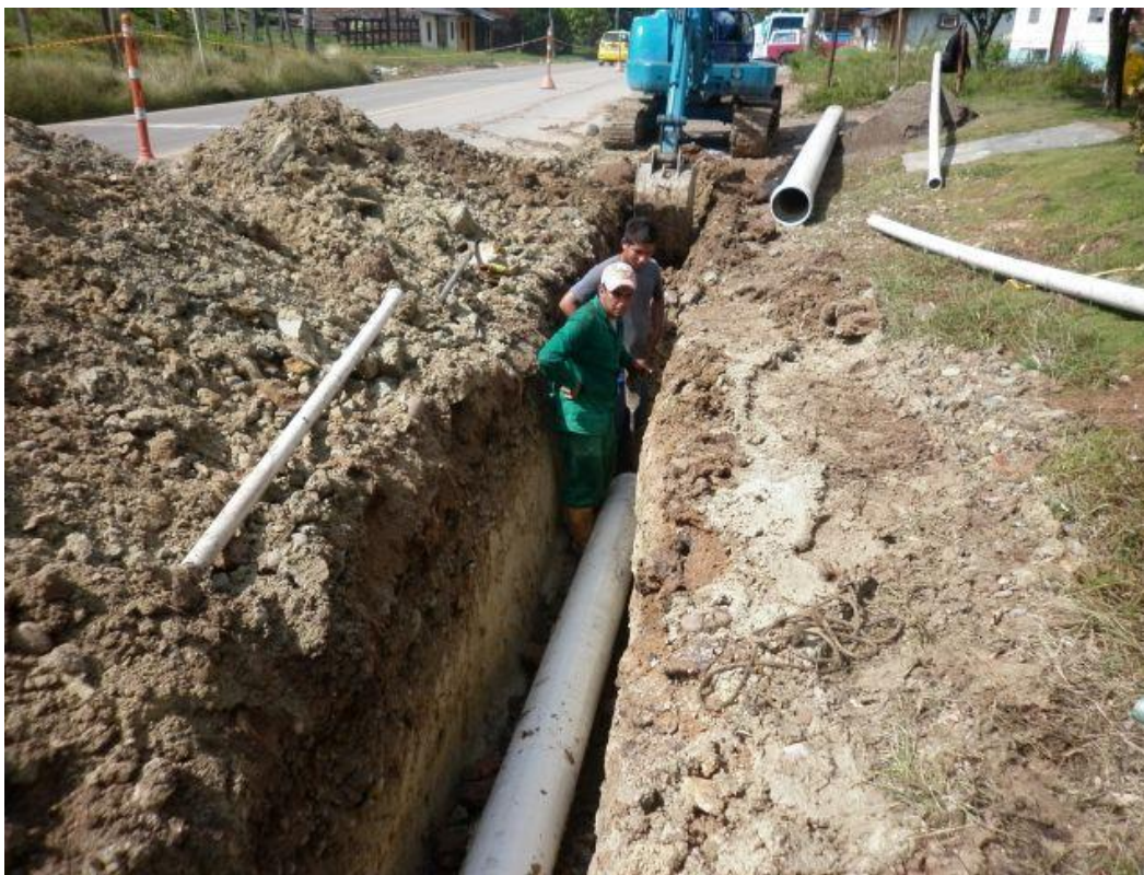
Foto No 41. Instalación tubería PVC 10”
