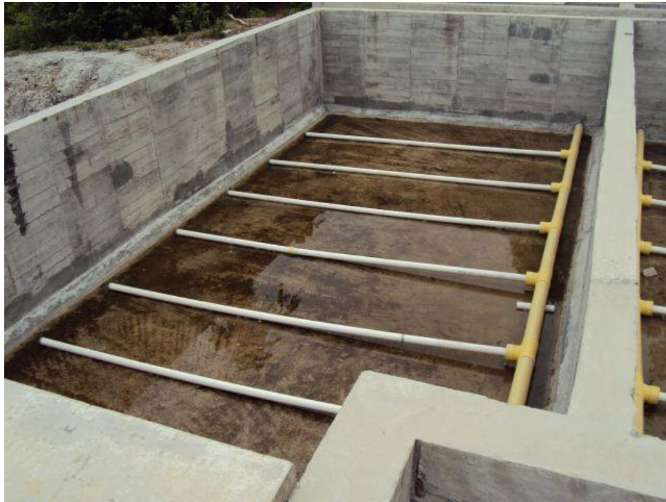
Foto No 30. Filtros Gruesos Tubería Perforada
