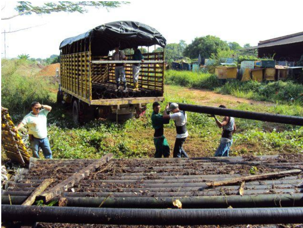
Foto No 23. Cargue de tubería en el patio de la secretaría de infraestructura
