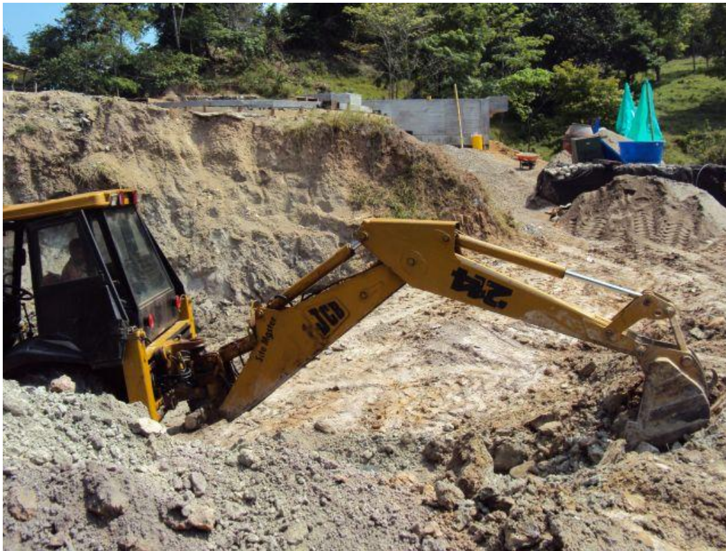
Foto No 36. Excavación y retiro de material
