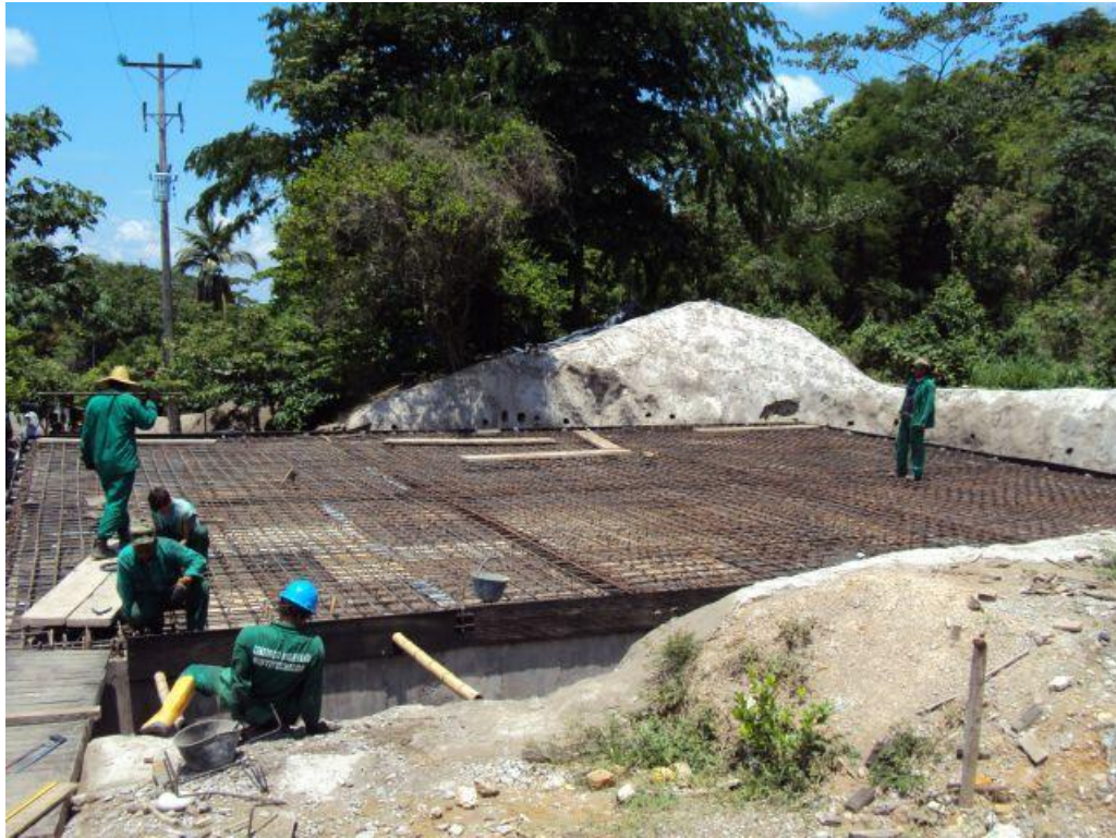
Foto No 39. Muros terminados y acero en la placa superior
