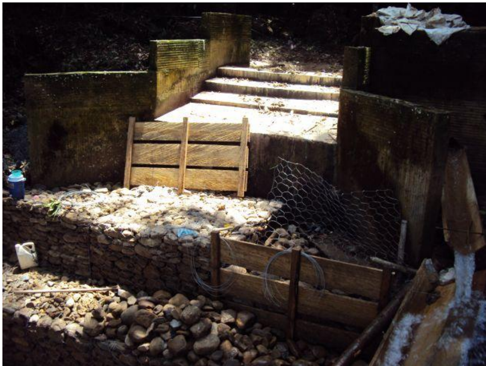
Foto No 15. Construcción de Gaviones para la bocatoma
