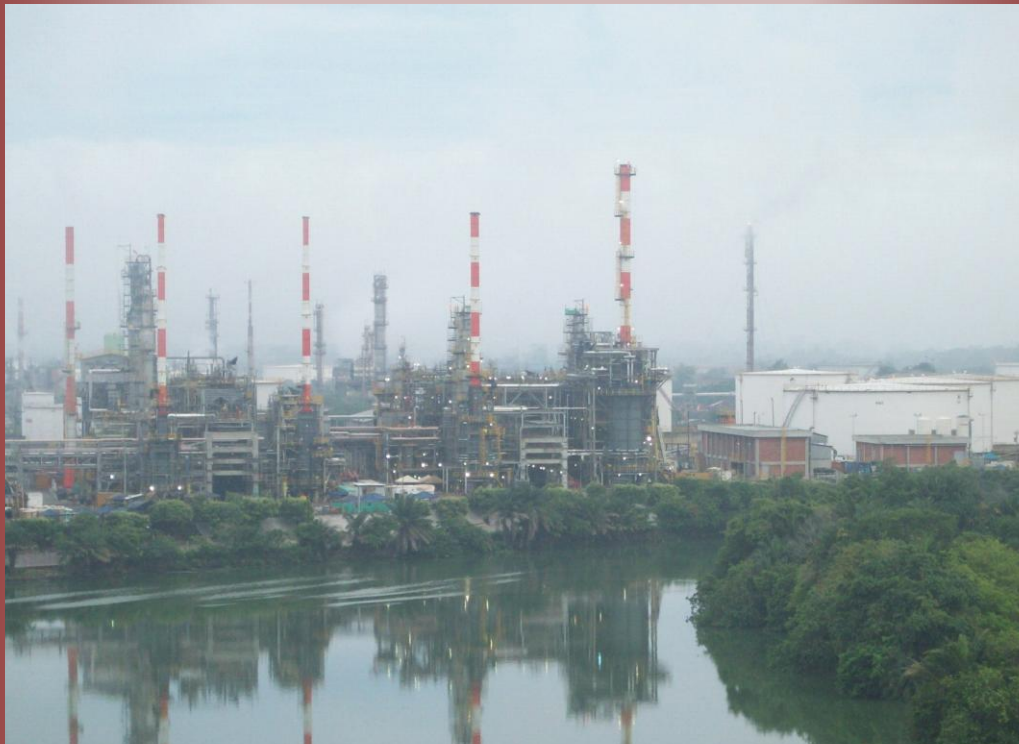
Foto No 6. Panorámica de la Refinería de ECOPEPETROL S.A. en Barrancabermeja
