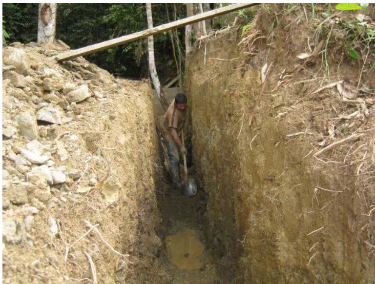
Foto No 19. Excavación para la conducción bocatoma – Desarenadores
