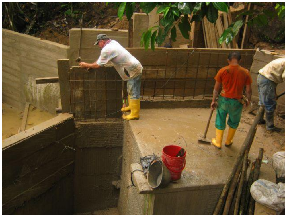
Foto No 16. Ampliación de aletas para la bocatoma
