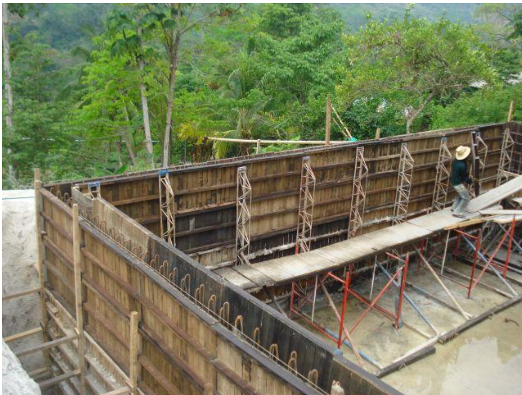
Foto No 38. Ubicación de formaleta para acero de refuerzo
