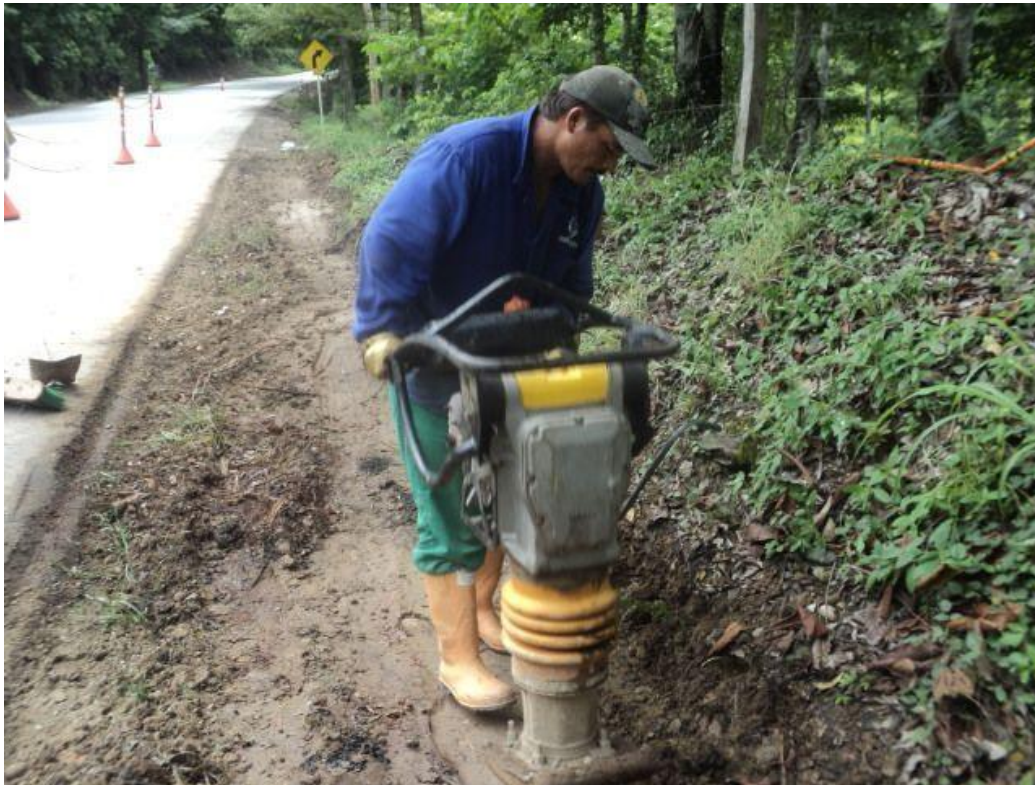
Foto No 42. Zanja de tubería PVC 10" rellena y compactada
