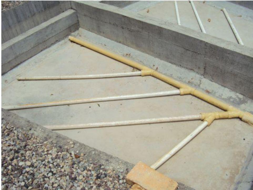
Foto No 30. Filtro Dinámico Tubería perforada
