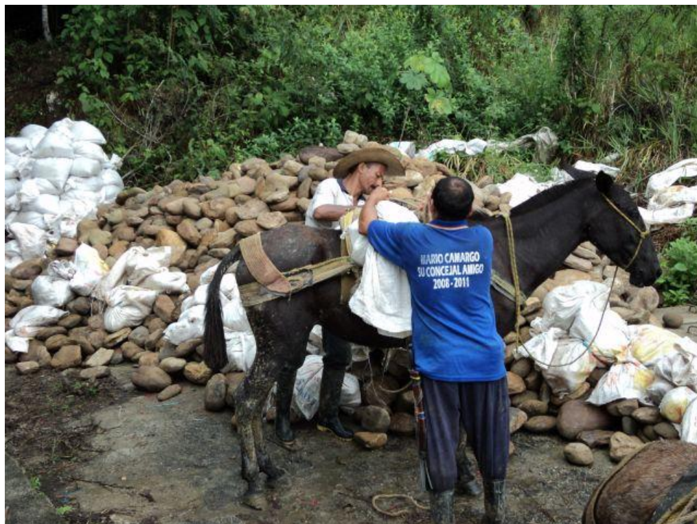
Foto No 14. Transporte Material para la bocatoma a lomo de mula
