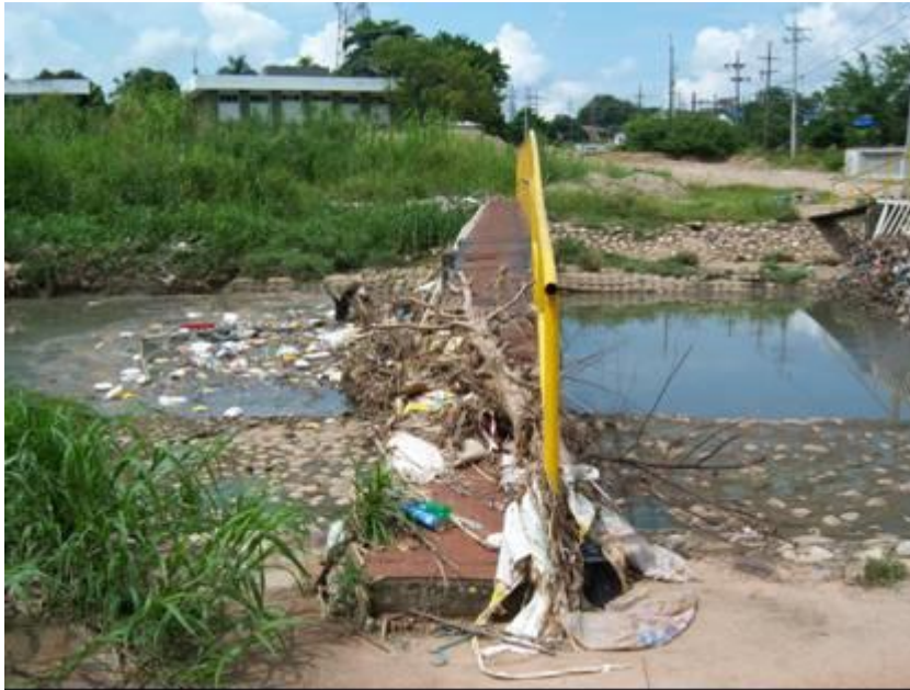
Foto No 15 Perdida de carga de 50 cm. Criba No 1 por represamiento de residuos sólidos
