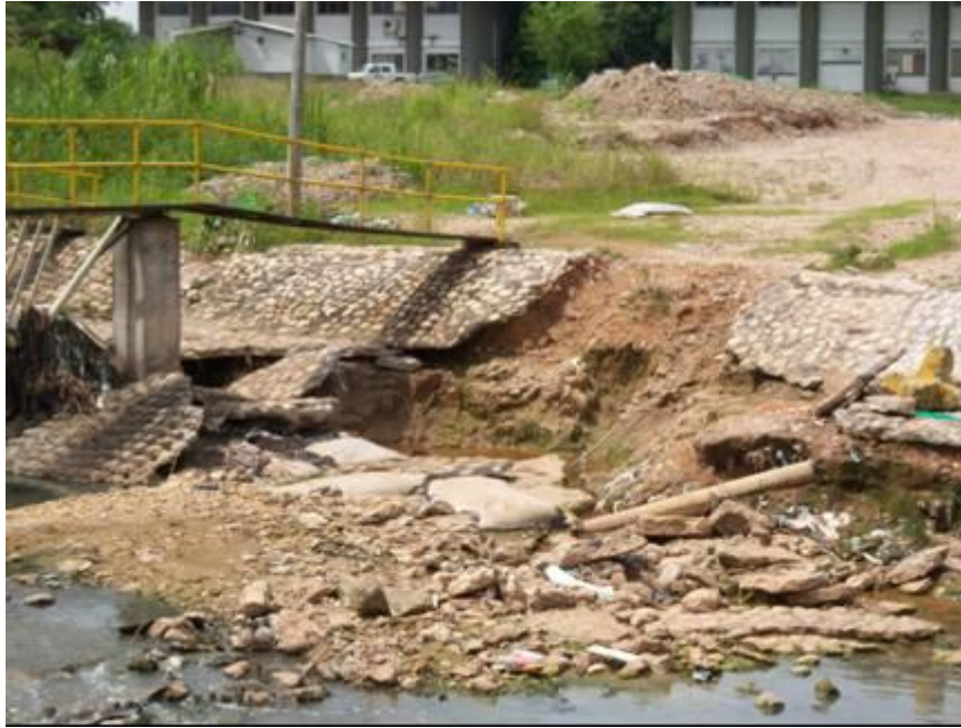
Foto No 13 Criba No3. Desestabilización del cauce del Caño Las Camelias, por desbordamiento del flujo ocasionado por el represamiento de residuos sólidos
