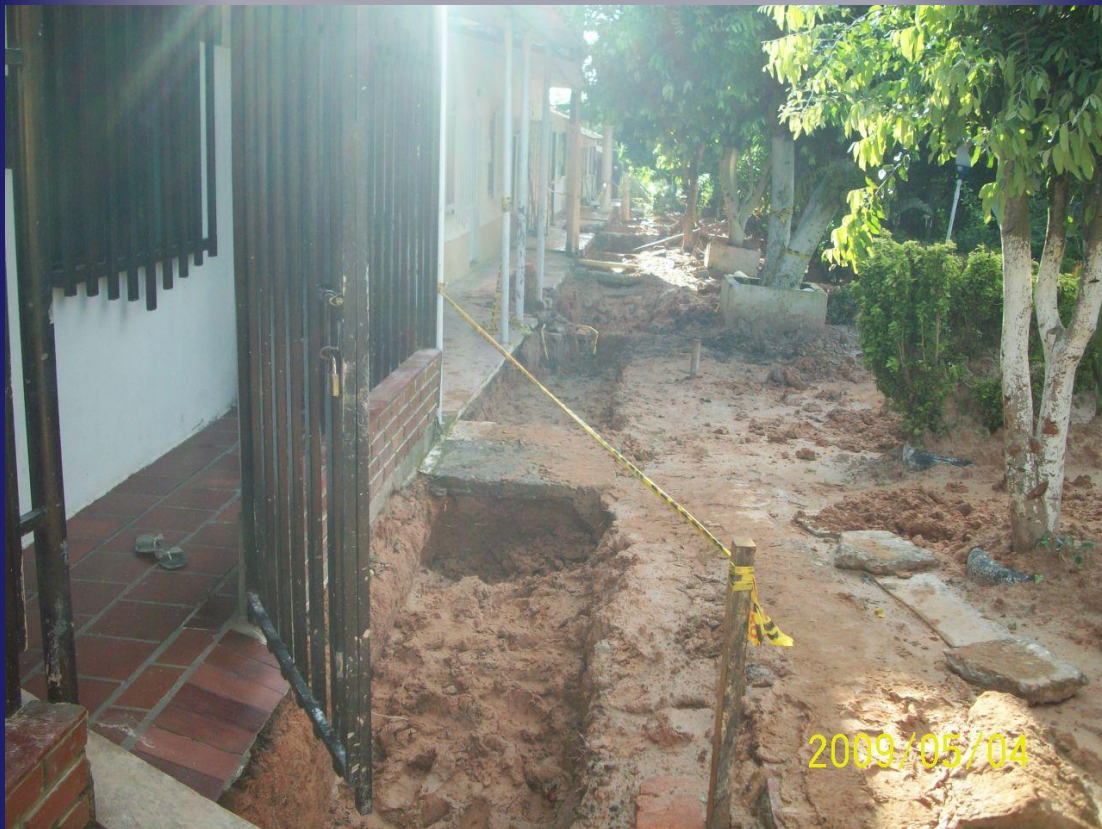
Foto No 3. Reposición de Red de Alcantarillado Municipio de Barrancabermeja
