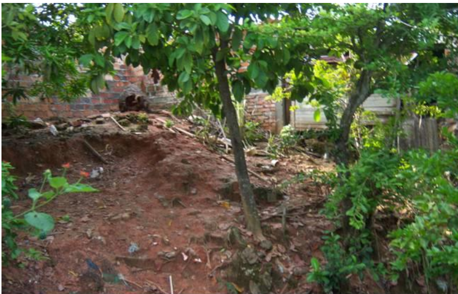
Foto N° 14 Asentamiento Villarelis II Relleno con escombros
