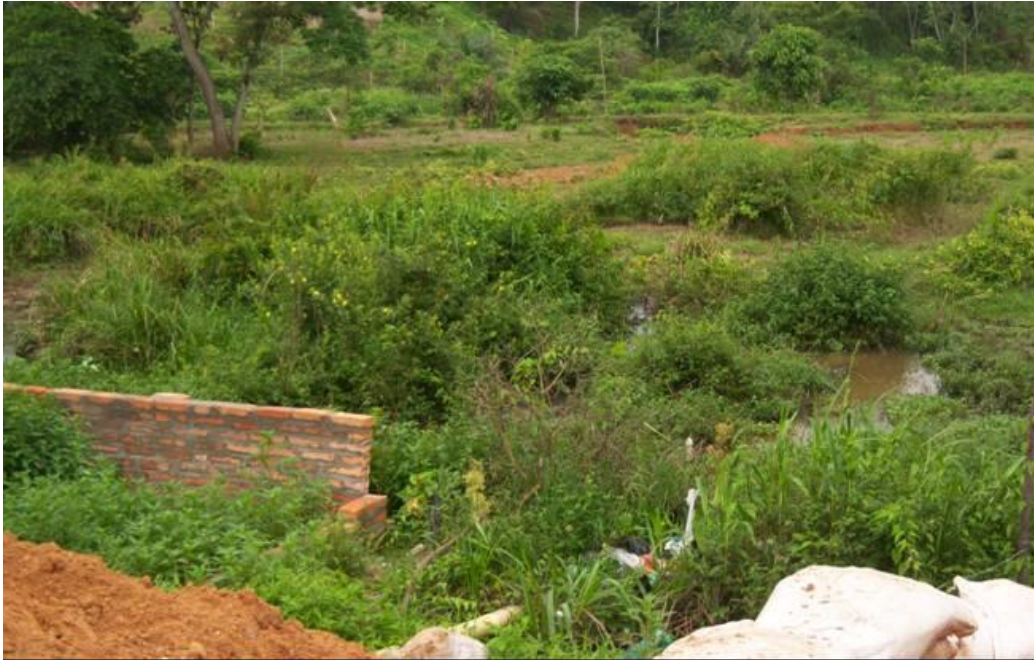
Foto N° 5. Asentamiento Villa Aura Rellenando un bajo inundable
