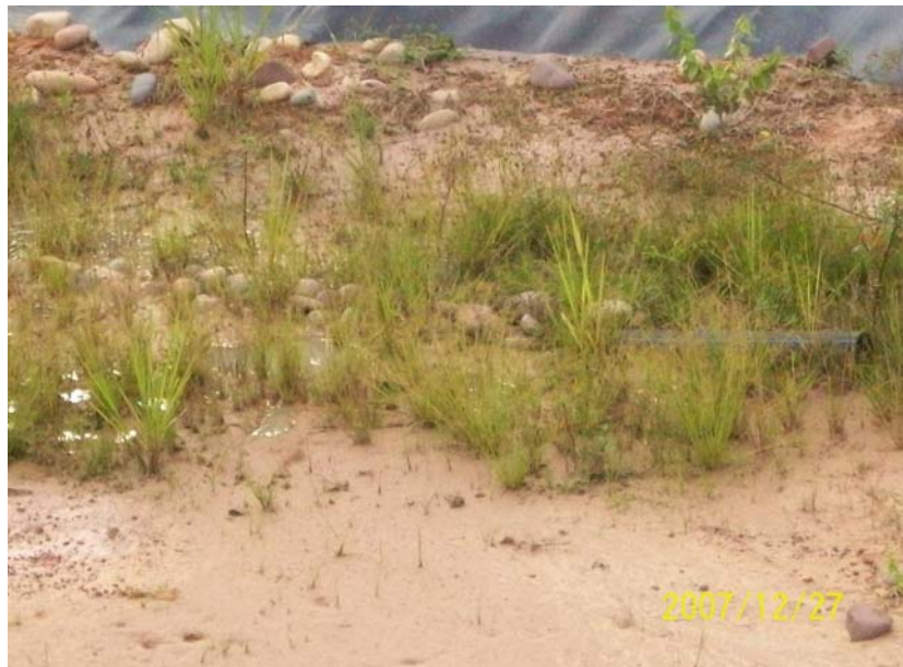
Foto N° 21. Tubería de Recolección de Lixiviados de la Celda Transitoria
