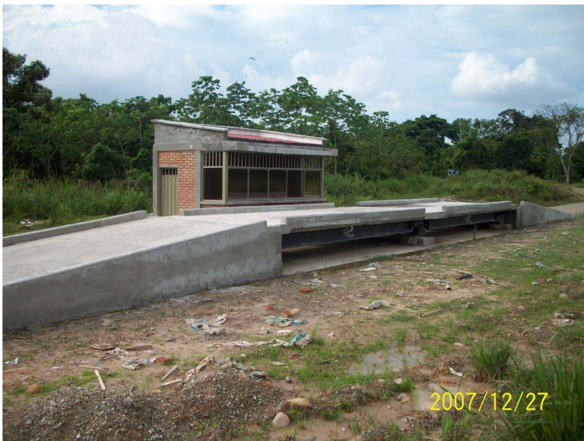
Foto N° 23. Balanza para Pesaje de los Residuos Sólidos que ingresan a la Celda Transitoria
