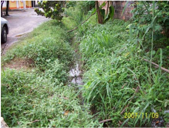
Foto N° 3. Ramal Principal del Caño Las Camelias, Barrio 20 de Agosto
