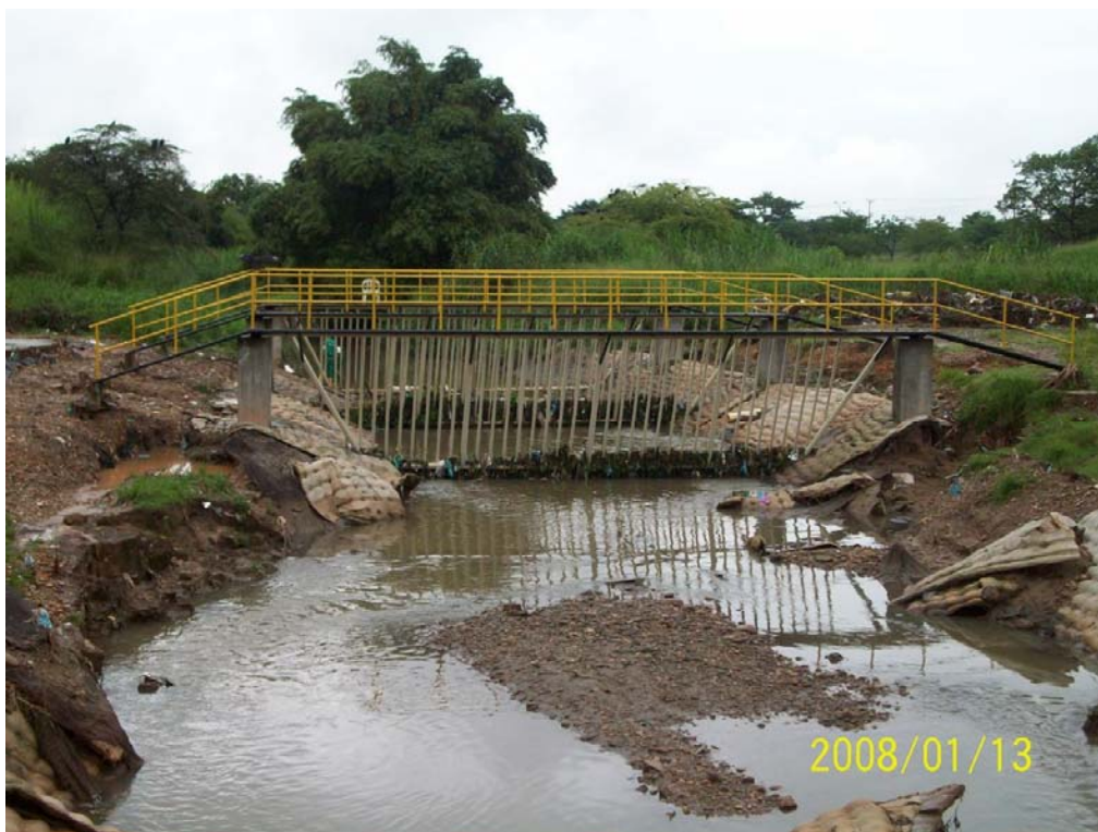
Foto N° 12. Transformación del Ecosistema Natural a un Sistema de Tratamiento de Agua Residual, Principal del Caño Las Camelias, Barrio Libertad
