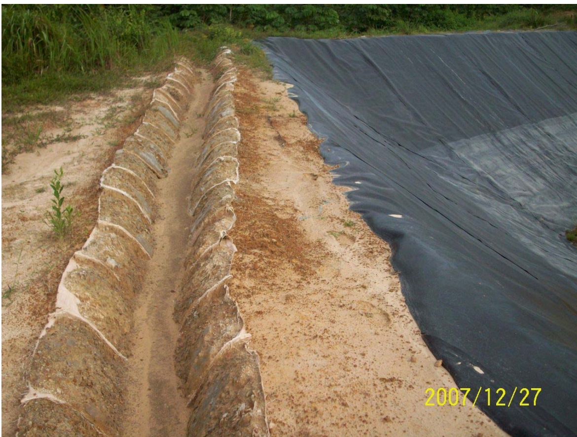
Foto N° 24. Canal Perimetral la Celda Transitoria
