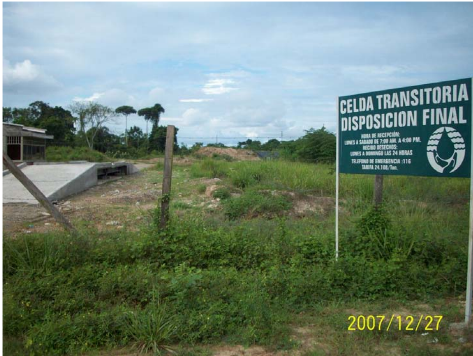
Foto N° 17. Celda Transitoria de Disposición de Residuos Sólidos. Barrancabermeja
