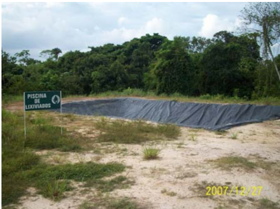
Foto N° 18. Piscina de Lixiviados de la Celda Transitoria de Disposición de Residuos Sólidos
