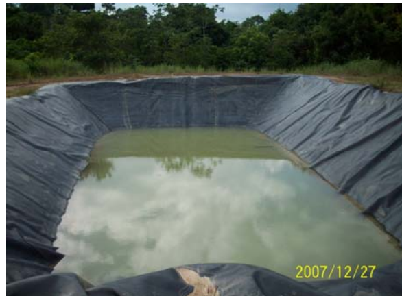
Foto N° 19. Almacenamiento de Agua Lluvia en la Piscina de Lixiviados de la Celda Transitoria
