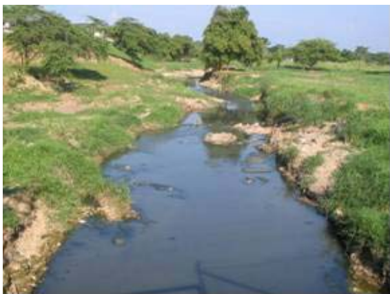
Foto N° 10. Canalización Inconclusa Caño Las Camelias
