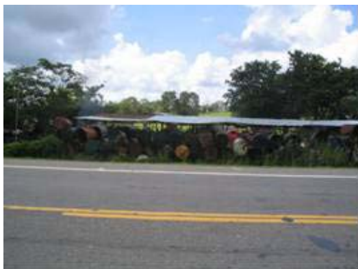
Foto N° 17. Procesadora de Asfalto
