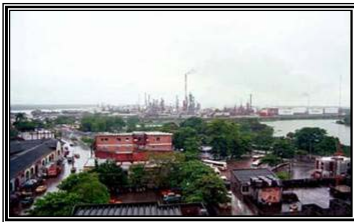
Foto N° 21. Panorámica de la Refinería GCB
