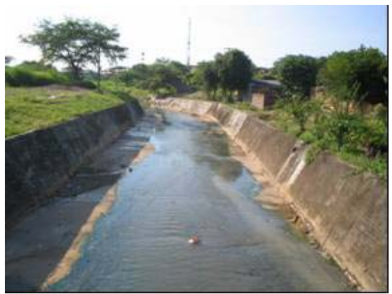
Foto N° 9. Canalización Talud Caño Las Camelias
