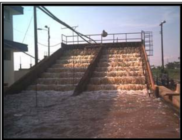
Foto N° 8. Sistema de Aireación Planta de Edasaba
