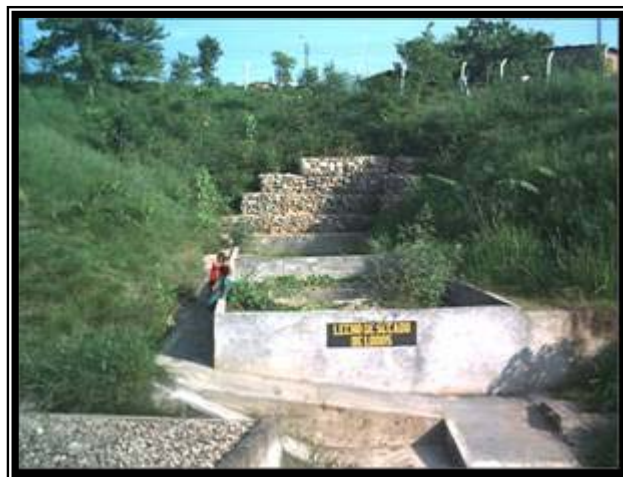
Foto N° 11. Área de secado de lodos PTAR Boston
