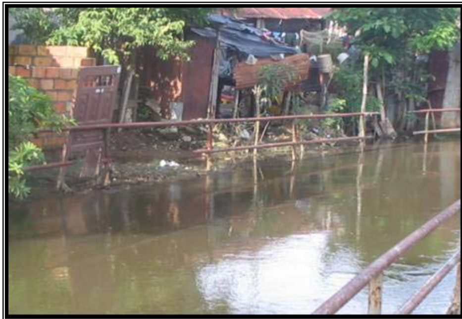
Foto N° 20. Inundación de Asentamientos Humanos Barrio Las Playa
