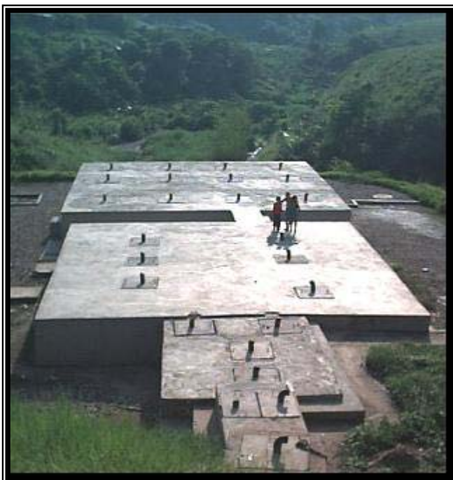
Foto N° 1. Planta de Tratamiento de Aguas Residuales del Barrio el Boston
